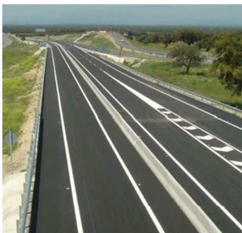
Construcción de Autovías y carreteras Extremadura
